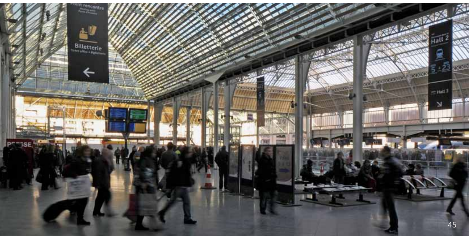
Ci-dessous : Gare de Paris-Lyon, réaménagement de la plateforme jaune - le nouveau complexe de liaisons verticales © SNCF-AREP / Photo M. Vigneau
