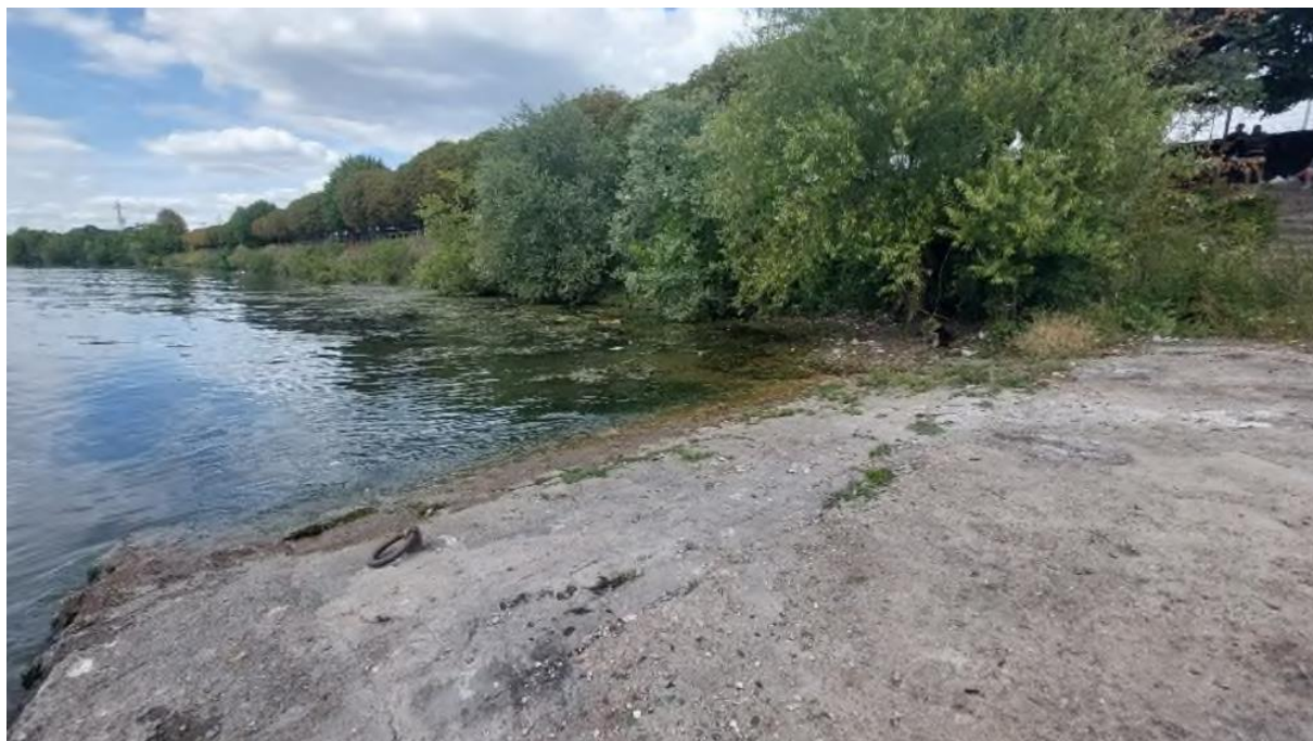
Figure 5: Photographie de la cale de mise à l'eau existante au nord du parking côté Seine (étude d'accostage et d'amarrage – étude faisabilité gare Villeneuve-Saint-Georges, ARTELIA, 2023)
