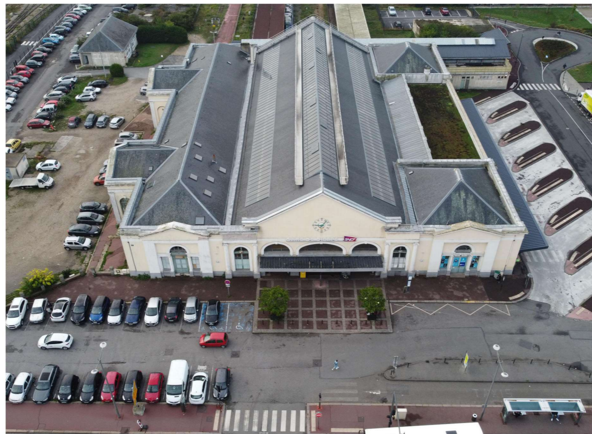
Vue sur la façade nord
