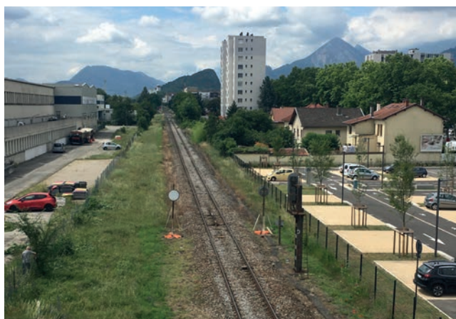
Environnement actuel de la future implantation du quai
