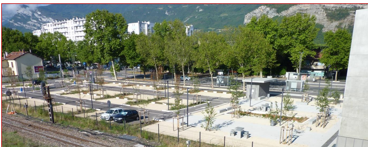
Figure 101 : Vue sur le parking-relais du pôle multimodal depuis la passerelle
