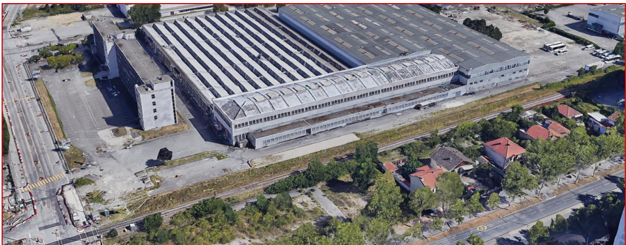
Figure 121 : Façade du bâtiment avec vue sur la nouvelle implantation de la halte voyageurs
