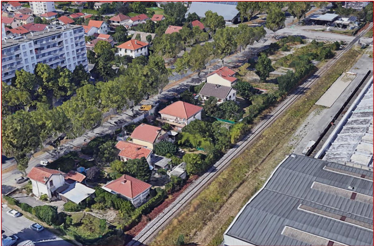
Figure 120 : Façades des habitations avec vue sur la nouvelle implantation de la halte voyageurs
