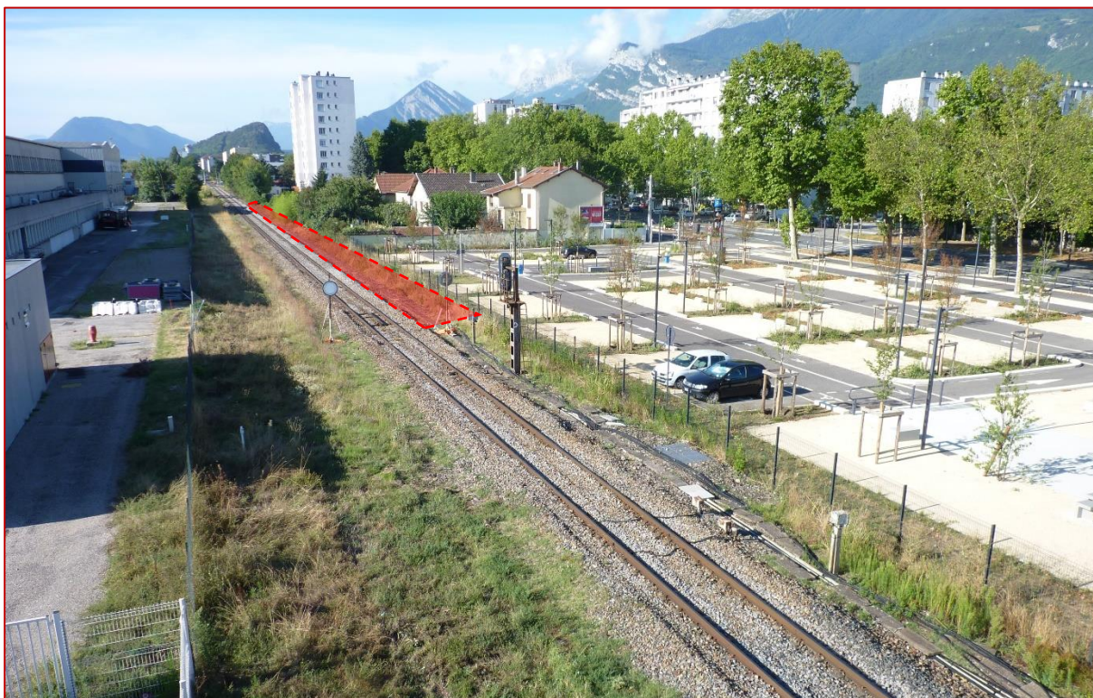
Figure 4 : nouvelle zone d'implantation de la halte voyageurs (vue depuis la passerelle enjambant la voie ferrée et prise en direction du sud), entre la voie ferrée et le parking du PEM de l'Étoile
