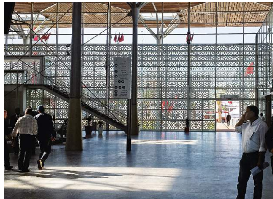
CASA-PORT, L'AIR DU LARGE — Les flux de navetteurs se croisent dans un vaste hall agrémenté de deux niveaux de magasins. Côté ouest, un moucharabieh contemporain filtre le soleil du soir et participe à la qualité de ce nouvel espace public de Casablanca.
